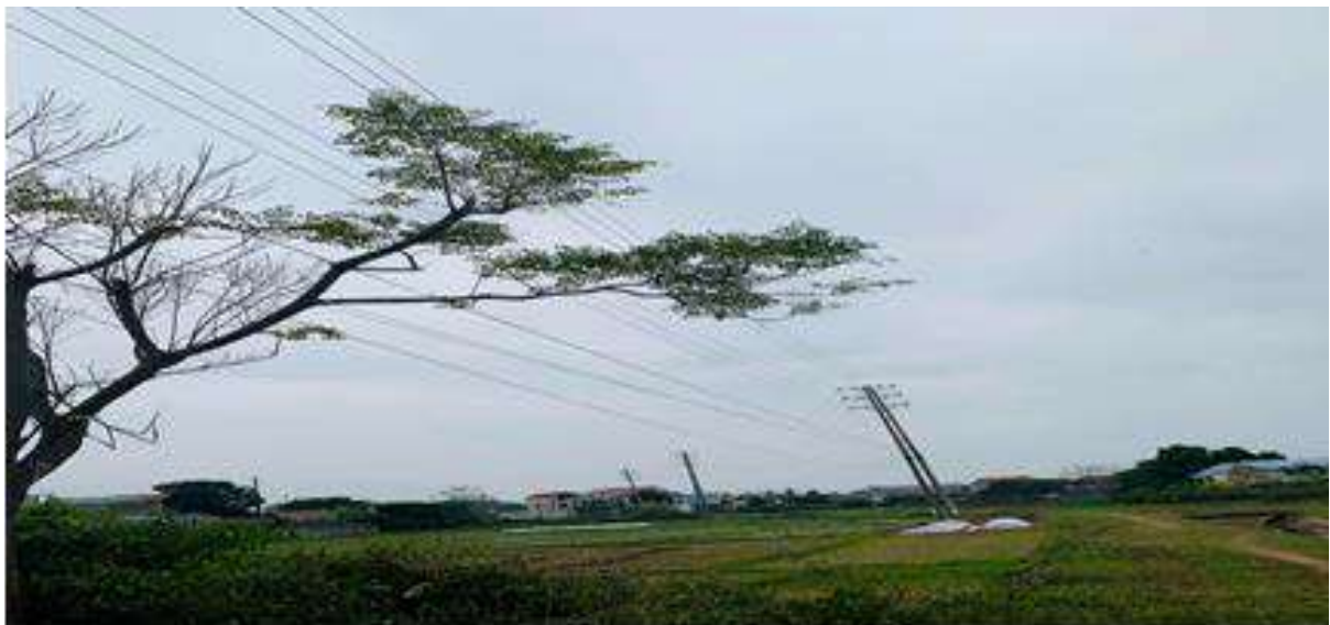
Hình 1.4. Đường dây gần ranh giới thực hiện Dự án
